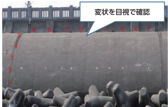
床版部外面の変状状況(補修前)
