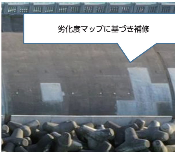
エリア毎の補修(補修後)
