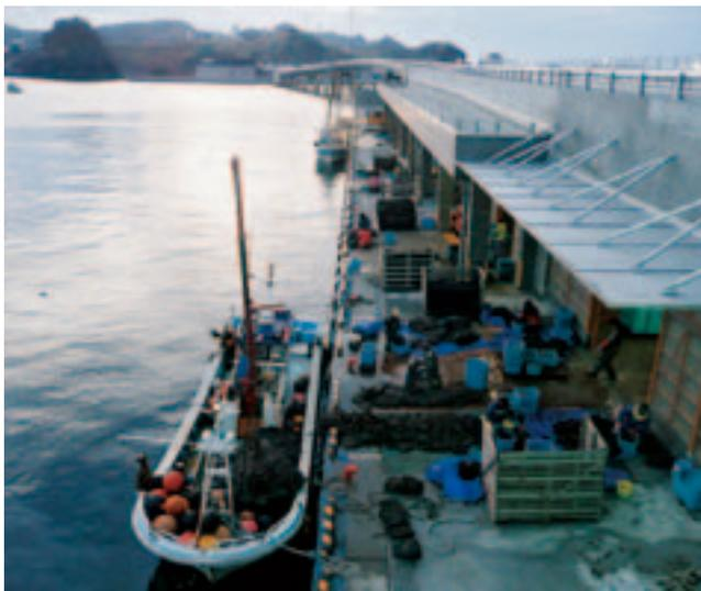
写真3 1階部 陸揚げ用3m屋根付き岸壁
