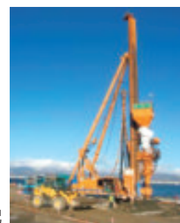
グラベルドレーン施工状況
