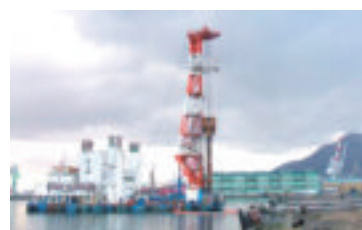
CDM 施工状況
