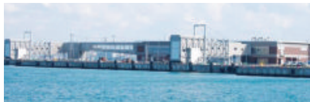
ボーディングブリッジを整備した稚内港フェリーターミナル
