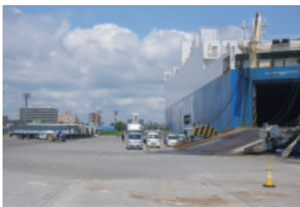
整備後：荷役効率・安全性が大幅に向上
