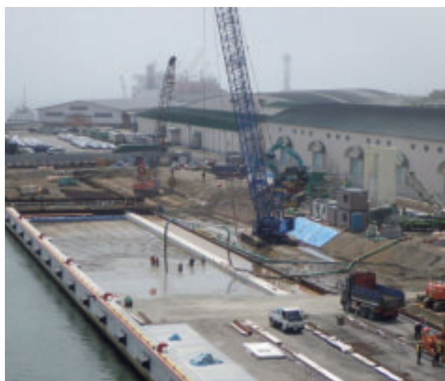
苫小牧港西港区西ふ頭施工状況（地盤改良）
