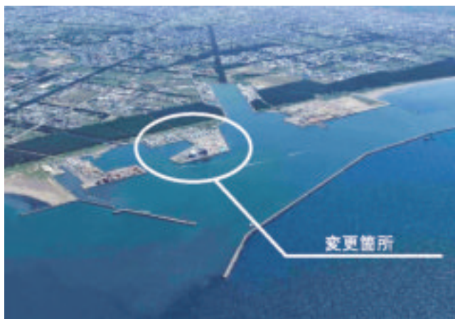
写真1：石狩湾新港全景
