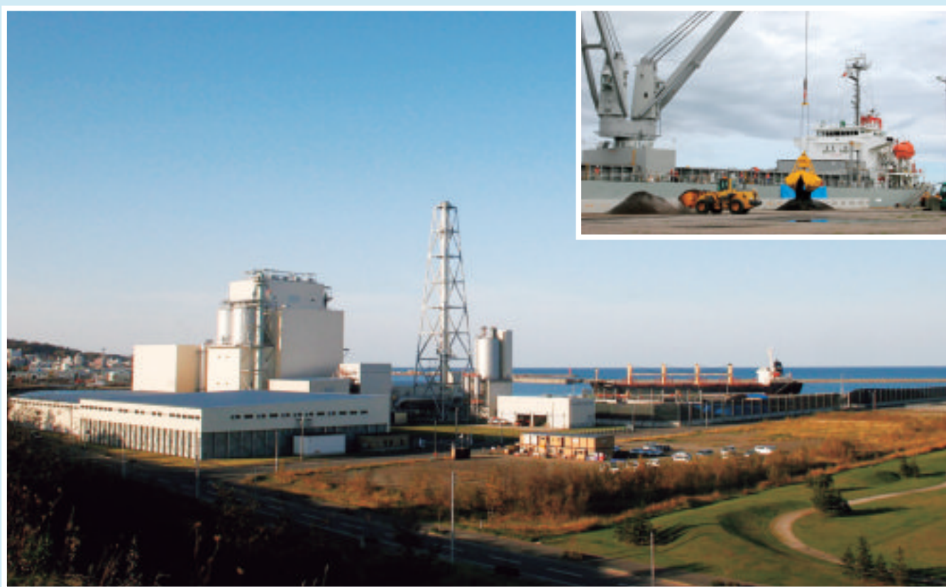
12月から運転開始した木質バイオマス火力発電所と使用燃料の荷役作業(写真提供:北海道開発局 紋別港湾事務所)
