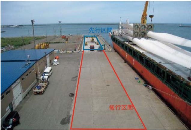
図-2 施工区間の分割と後行区間を利用した陸揚げ作業
