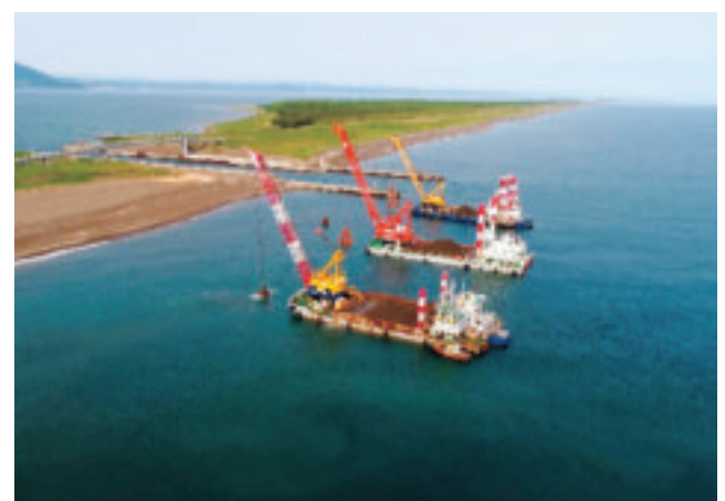
写真-1 サンドポケット浚渫状況
