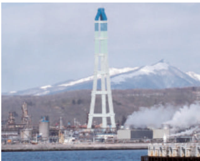
JXTG エネルギー(株)の集合煙突
