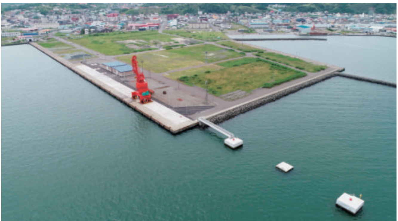
係船柱(ビット)整備状況 (H30.7.3)
