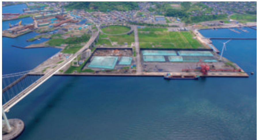
祝津埠頭全景（右側が祝津埠頭岸壁）
