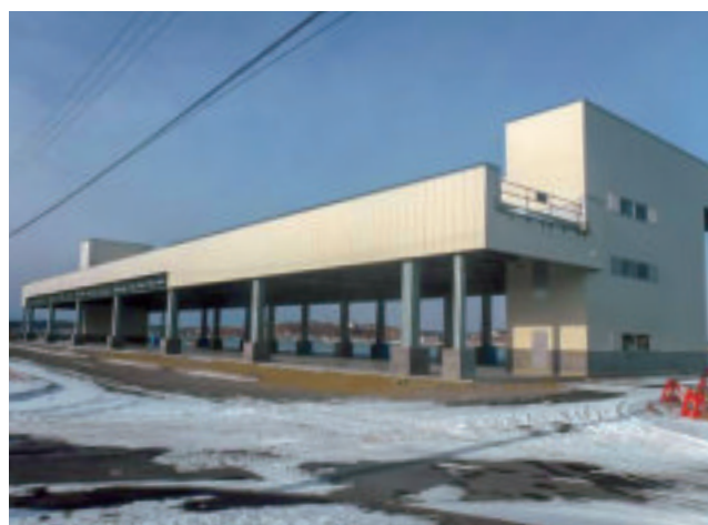
図-3 概成した人工地盤部(1階部分は漁協の荷さばき所が整備され、2階部分は漁業関係者の駐車場として利用)
