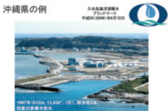
図12. 空から見た沖縄県久米島の海洋深層水取水施設と沖縄県海洋深層水研究所
