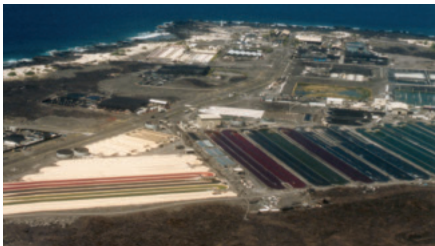
図 16. HOST Park の上空からハワイ自然エネルギー研究所を見たところ
