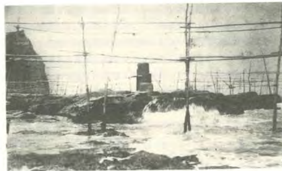
図4・14 国内で最初の波力利用の海域実験装置
