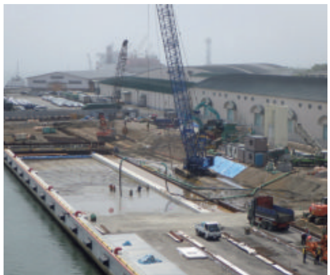
苫小牧港西港区西ふ頭施工状況（地盤改良）
