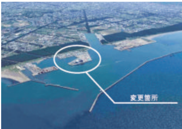
写真1：石狩湾新港全景
