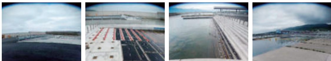
写真. 工事竣工後の現地状況 (自社撮影)
