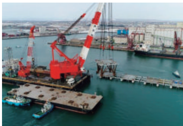
写真-2 ジャケット据付状況
