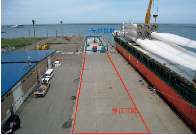
図-2 施工区間の分割と後行区間を利用した陸揚げ作業
