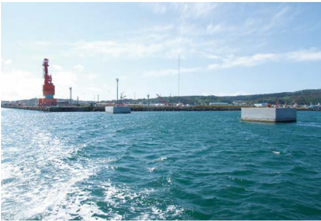
図-3 ビット完成状況
