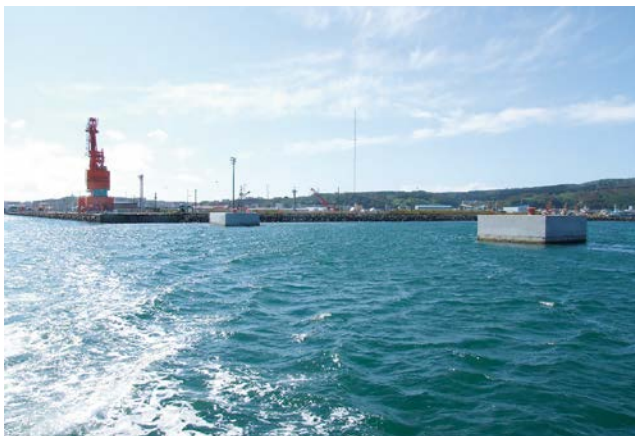
図-3 ビット完成状況
