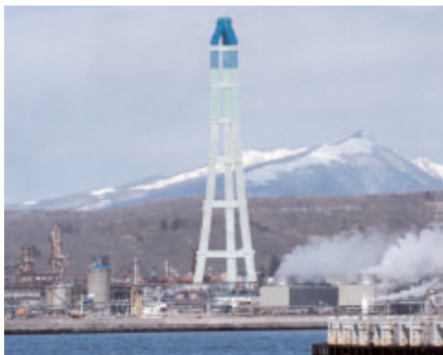
JXTG エネルギー(株)の集合煙突
