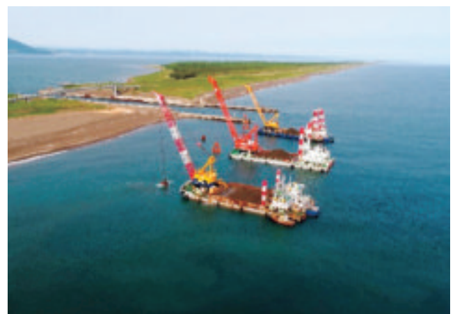
写真-1 サンドポケット浚渫状況
