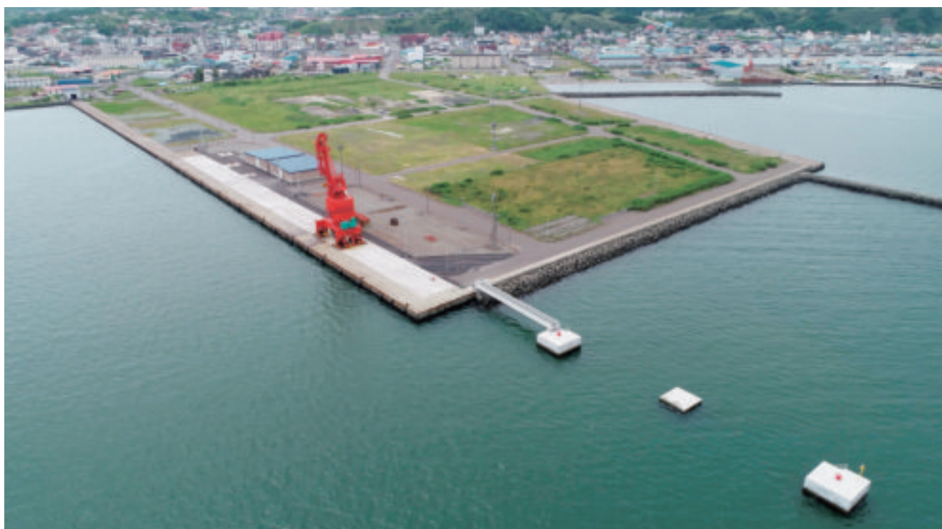
係船柱(ビット)整備状況 (H30.7.3)
