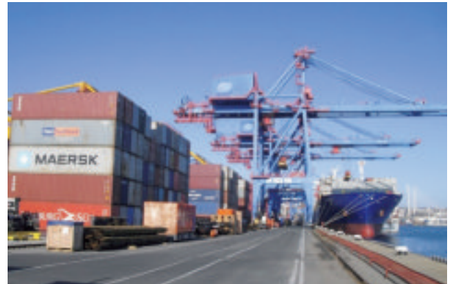
ウラジオストク港 コンテナバース（3B） (ガントリークレーン 6 基、実入りコンテナ 5 段積、最大入港 実績 4,000TEU/ 隻、岸壁水深ー 10.5 ～ー 13.2m)
