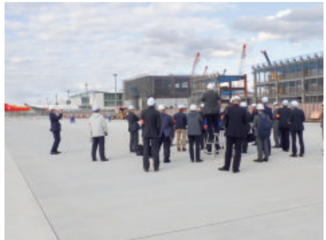
見学状況（国際線エプロン工事）
