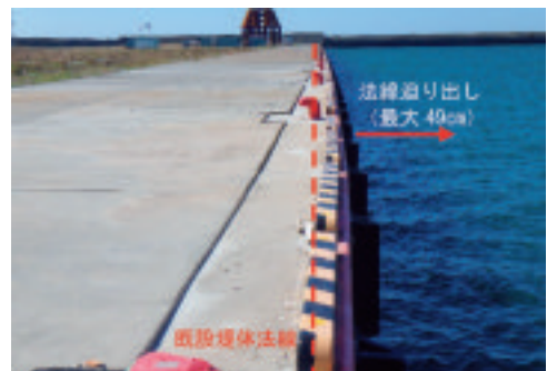
写真-① -4M物揚場本体法線の変位状況
