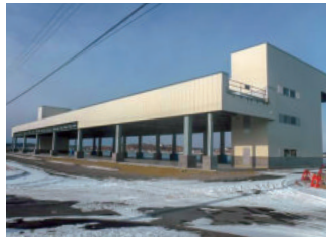
図-3 概成した人工地盤部(1階部分は漁協の荷さばき所が整備され、2階部分は漁業関係者の駐車場として利用)
