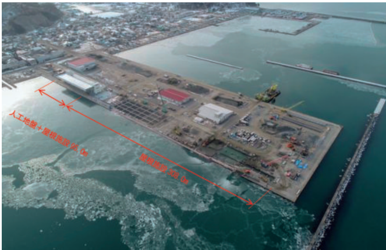
図-4 整備が進む衛生管理対策施設（厚岸漁港湖南地区第2埠頭）
