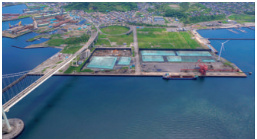
祝津埠頭全景（右側が祝津埠頭岸壁）
