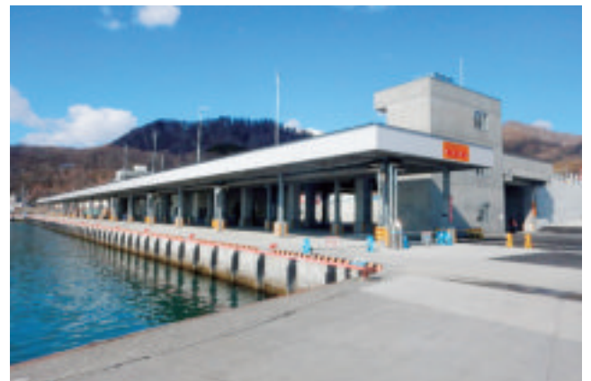
屋根付き岸壁
