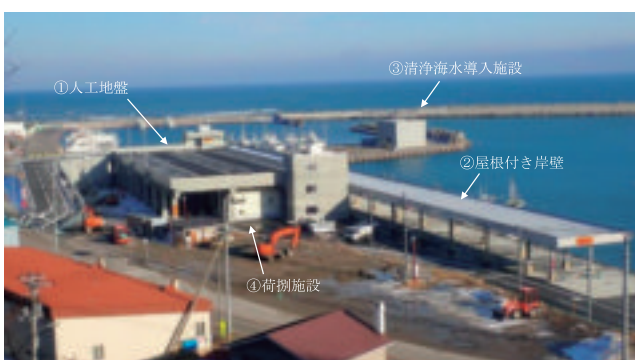
衛生管理施設全景
