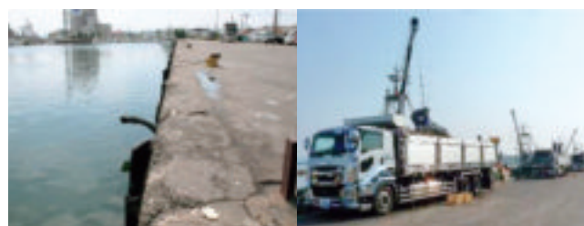
係留施設の老朽化・ホタテガイの水揚げ状況（整備前）
