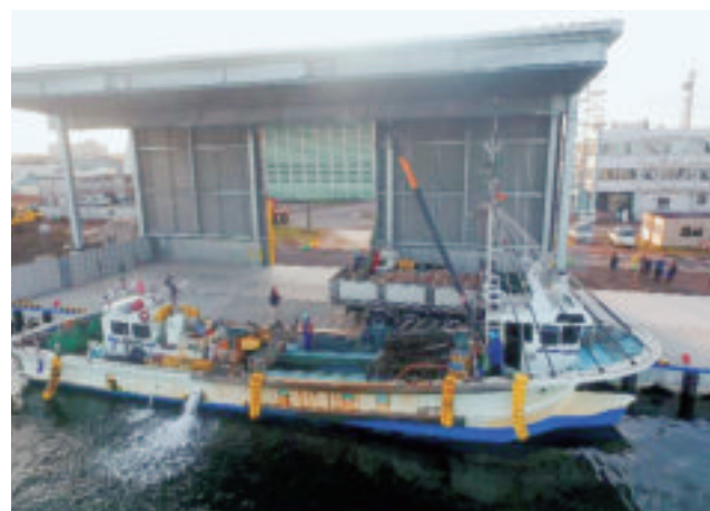
屋根付き岸壁（暫定供用箇所）
