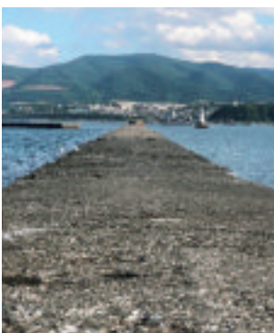
小樽港北防波堤…建設から100年以上経過した現在も第一線防波堤として機能を果たしている。
