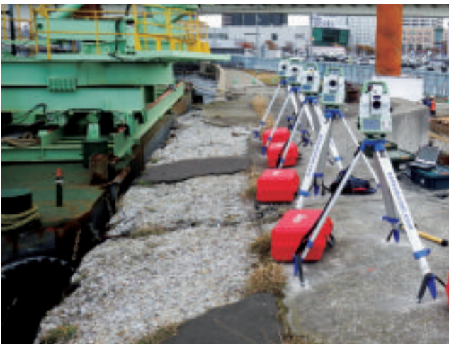
3D 鋼管杭打設管理システムによる無人化自動観測
