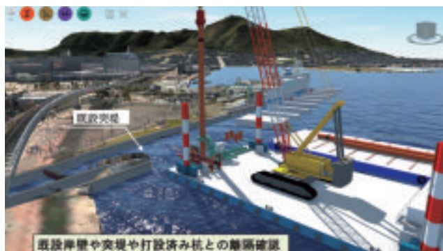
図-2 ドルフィン施工状況のシュミレーター
