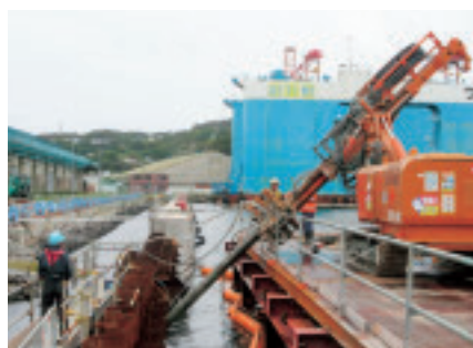
斜めアンカー削孔状況
