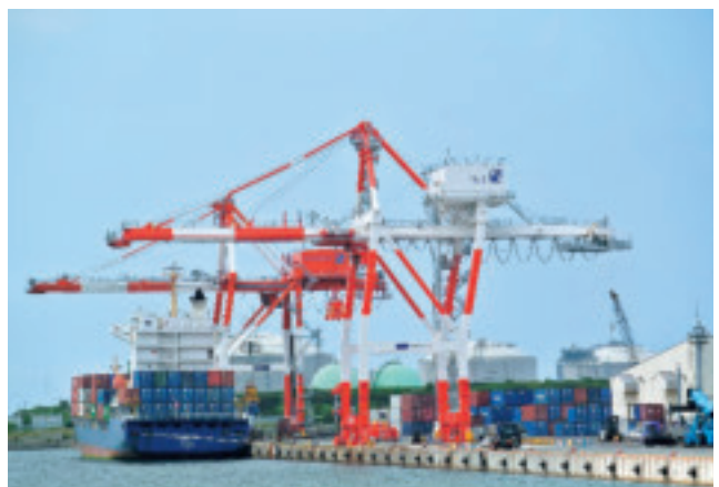
ガントリークレーン 2号機(手前)と1号機(奥)
