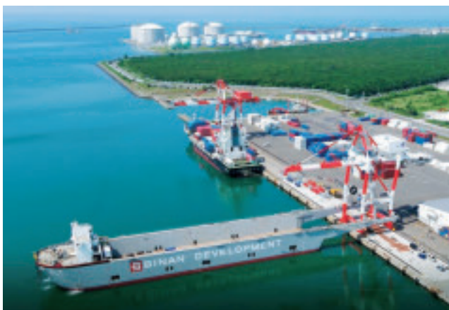
大型特殊台船「天佑」による フォークオフ工法での2号機設置状況
