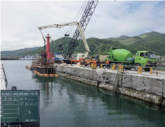
写真9 -3.5m岸壁水中コンクリート打設状況
