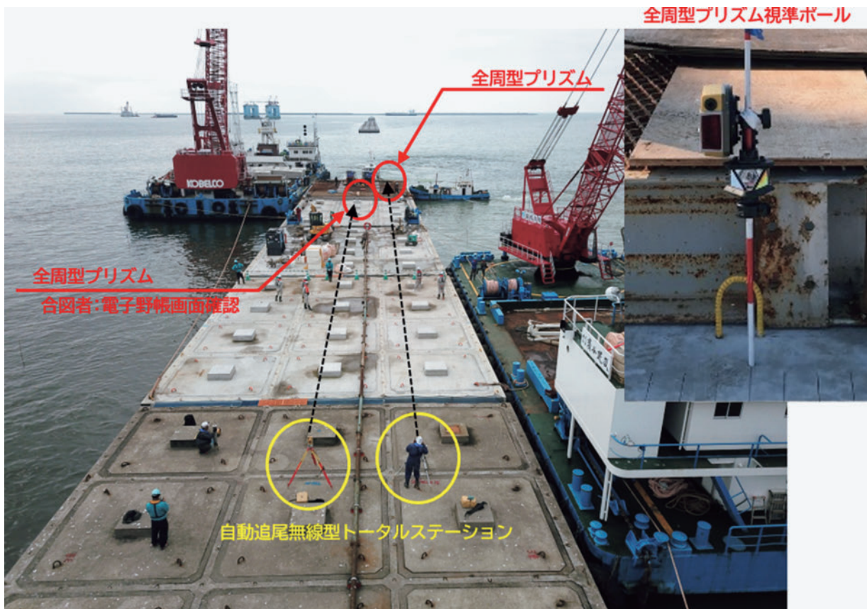
写真5 自動追尾無線型トータルステーションによる据付ケーソン誘導
