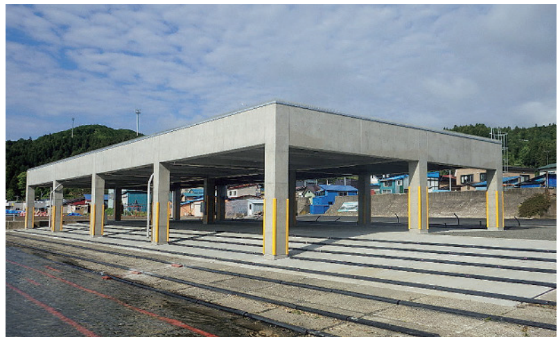
完成した屋根付き船揚場
