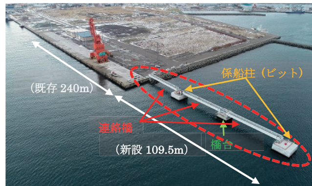
係留ビット完成状況
