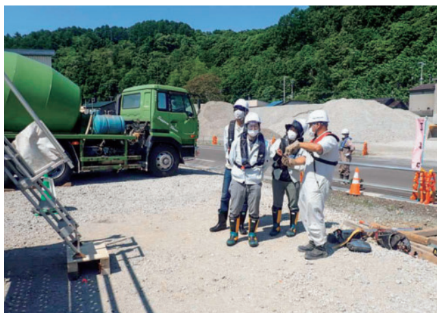
工事の内容説明を受ける
