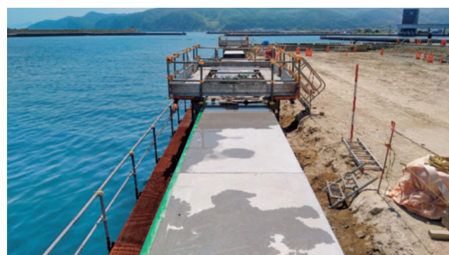
岸壁上部工の施工状況
