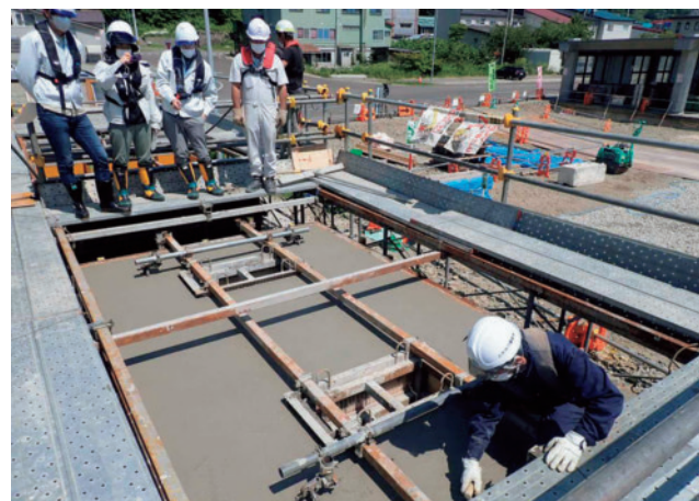
根固方塊製作の足場の上って見学・確認
