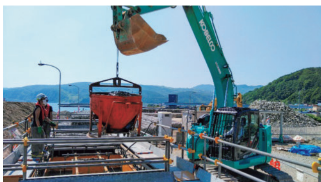
根固方塊のコンクリート打設作業
