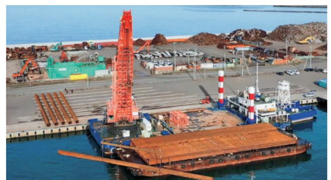
写真4 鋼管矢板の荷下ろし状況(東ふ頭)
