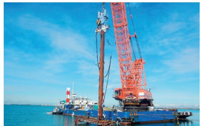
写真3 控え鋼管矢板の打設状況(1本目)
