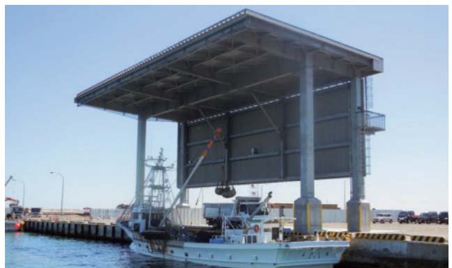
完成した屋根施設
