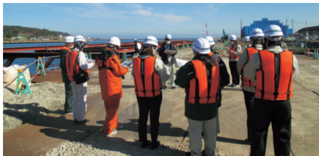
-10m岸壁工事現場視察の様子
