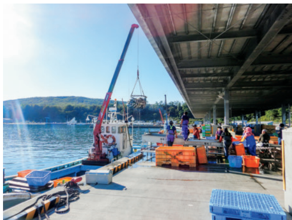
屋根付き岸壁
