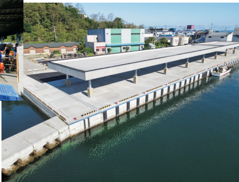
屋根付き岸壁全景
