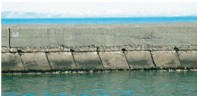
写真-4 傾斜積ブロック
