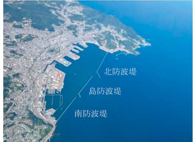
写真-1 小樽港防波堤施設
