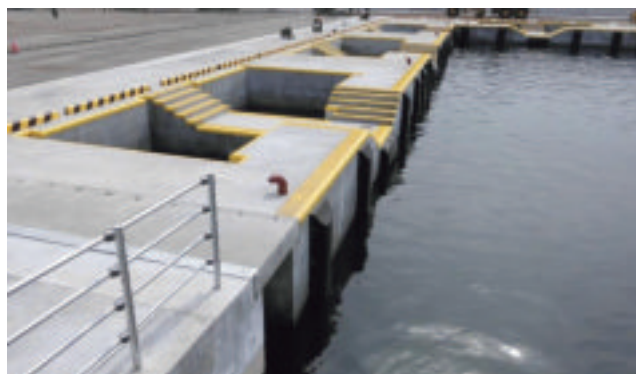
写真3 蓄養施設における低天端状況
