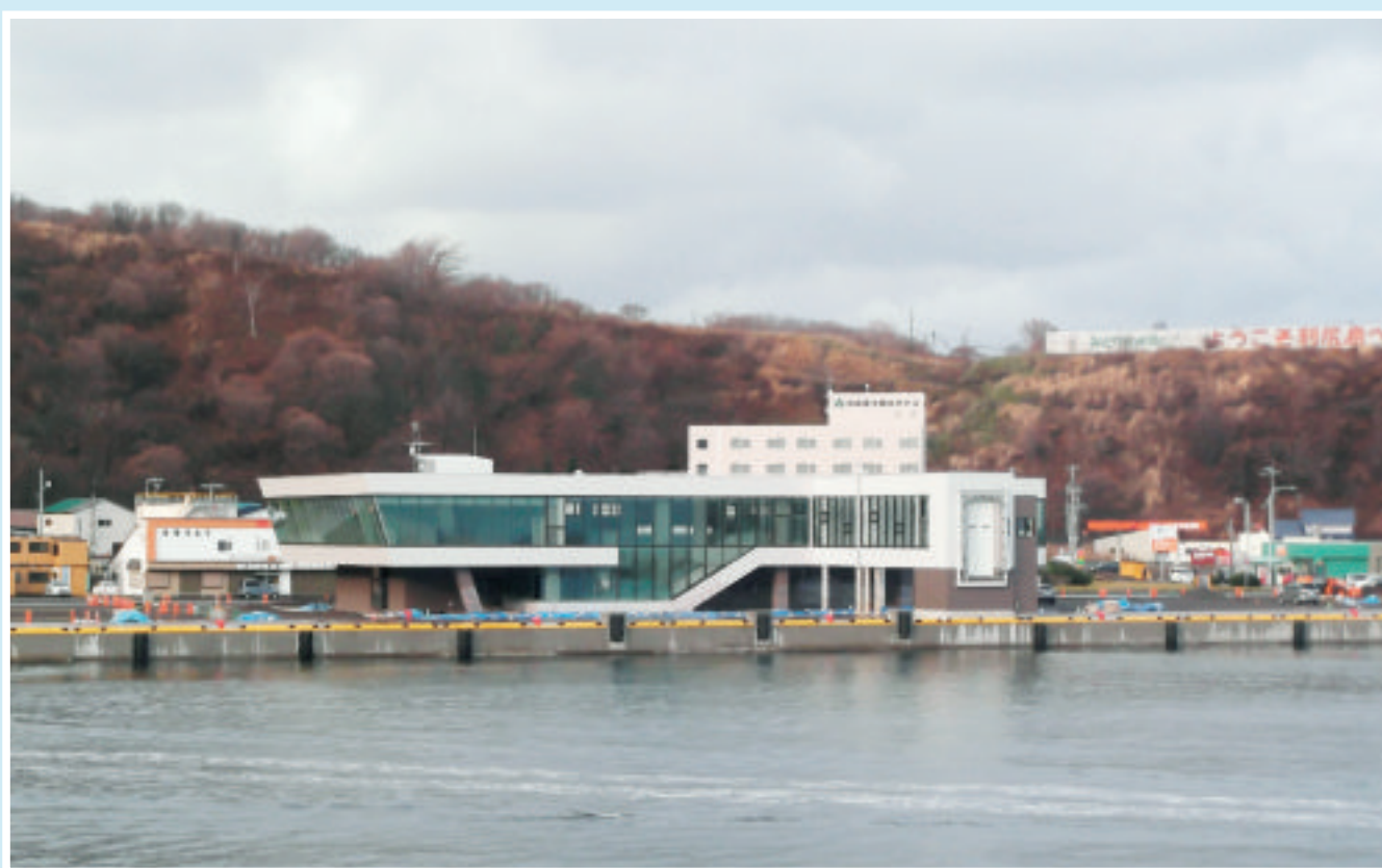
鷺泊港改良岸壁と新フェリーターミナル(稚内開発建設部提供)
