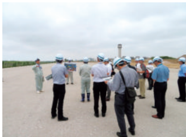
見学状況（誘導路新設工事）
