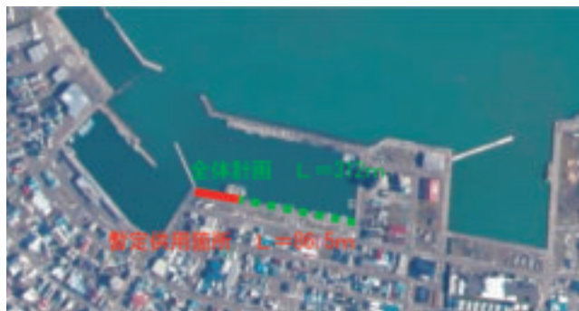
紋別港港町地区（整備箇所）
