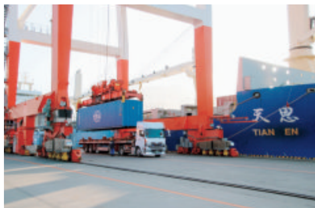
コンテナ荷揚げの様子
