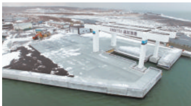
完成した船揚場上架施設
