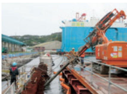
斜めアンカー削孔状況
