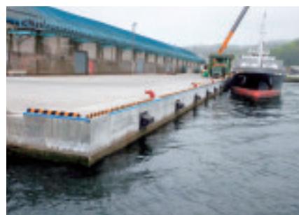
事業完了後の岸壁利用状況
