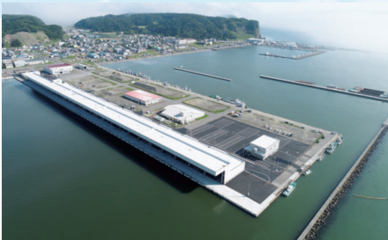
供用開始した厚岸漁港衛生管理施設(釧路開発建設部)
