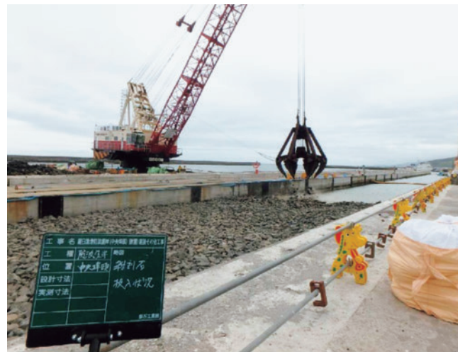
写真 10 用地裏込石投入状況
