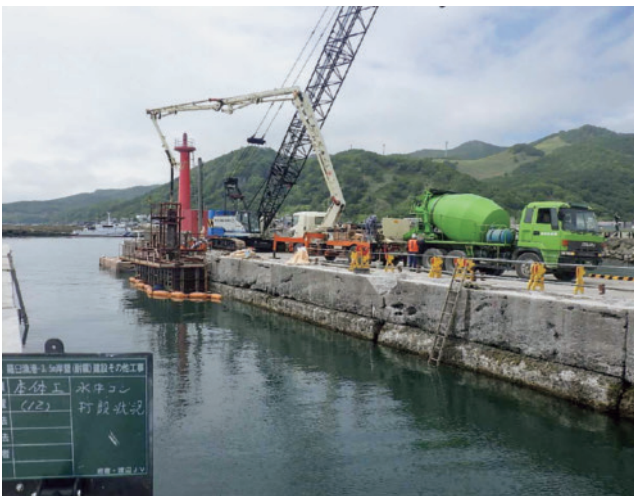
写真 9 ー3.5m 岸壁水中コンクリート打設状況
