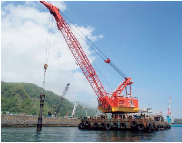
写真 7 防波護岸基礎捨石モンケン均し状況
