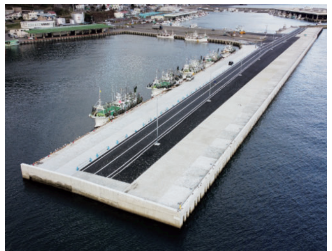
写真 12 中央埠頭完成
