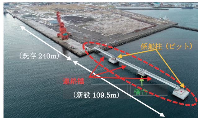
係留ビット完成状況
