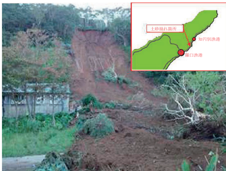
写真2 道道87号線の土砂崩れ状況
