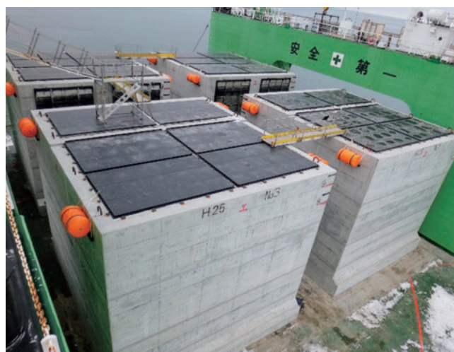
写真3 FD上のスリットケーソン
