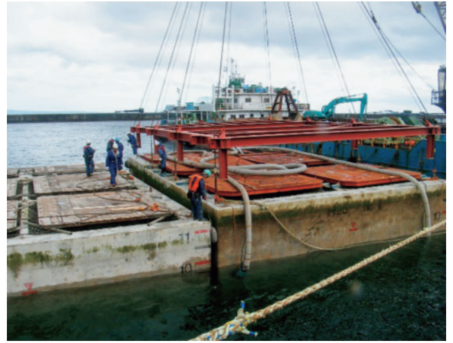
写真 8 防波護岸スリットケーソン据付状況
