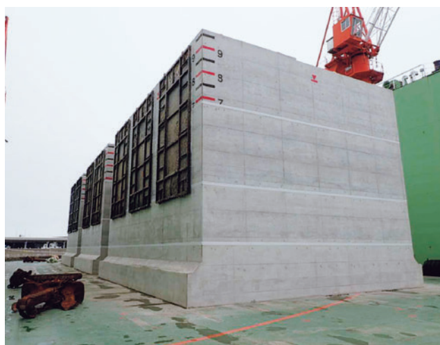
写真4 FD上のスリットケーソン
