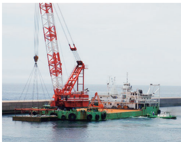
写真6 スリットケーソンい航状況
